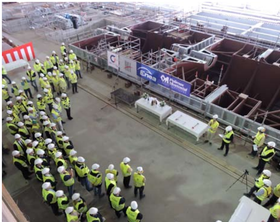
Rys. 21. Oficjalne rozpoczęcie montażu turbozespołu
