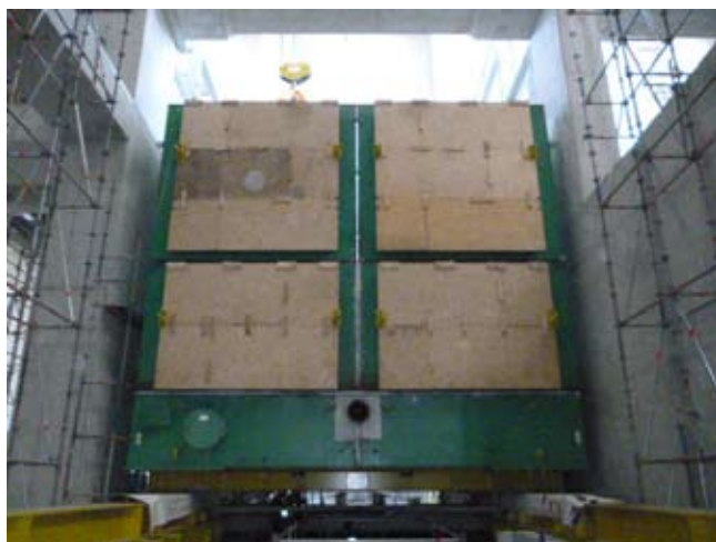
Rys. 9. Kondensator w trakcie montażu
