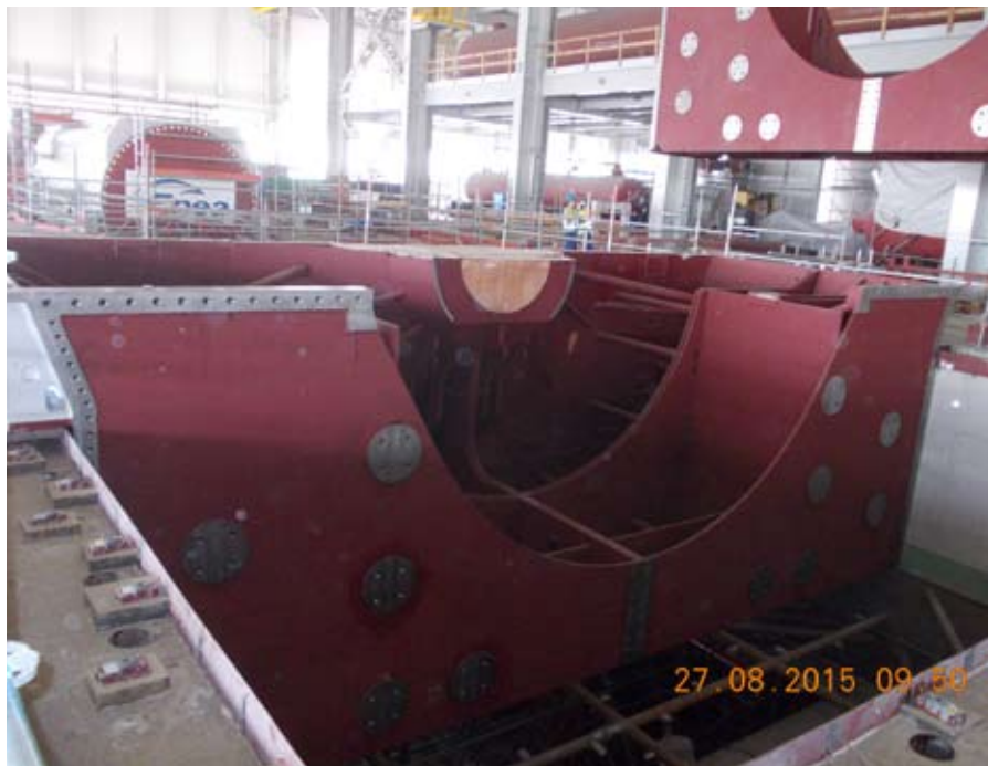
Rys. 16. Montaż elementów dolnego korpusu zewnętrznego części niskoprężnej
