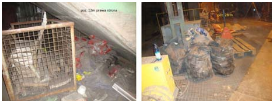
Rys. 3 i 4. Przykłady problemów z gromadzeniem i usuwaniem odpadów podczas remontu kotła
