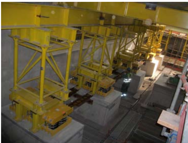
Rys. 7. Tymczasowa konstrukcja wsporcza do transportu poziomego kondensatora
