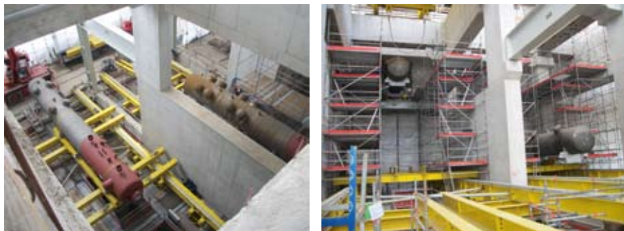
Rys. 8. Wymiennik w trakcie montażu na poziomie +9m
