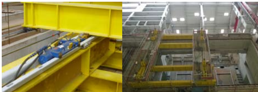
Rys. 10. Siłownik do przepychania oraz konstrukcja wsporcza do podniesienia kondensatora
