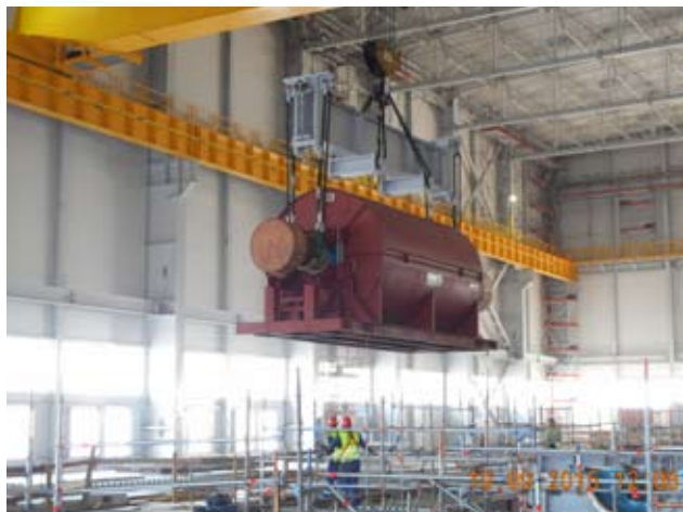
Rys. 18. Rozładunek wirników części niskoprężnej
