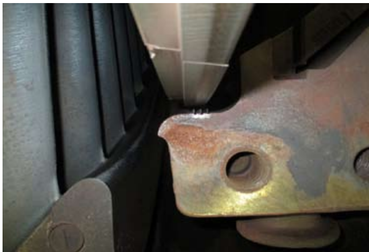
Rys. 8. Uszczelnienie nadbandażowe stopnia 3 przed modernizacją
