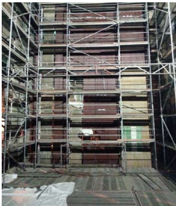
Rys. 1. Widok komory paleniskowej z widocznymi nowymi elementami parownika podczas remontu kapitalnego kotła
