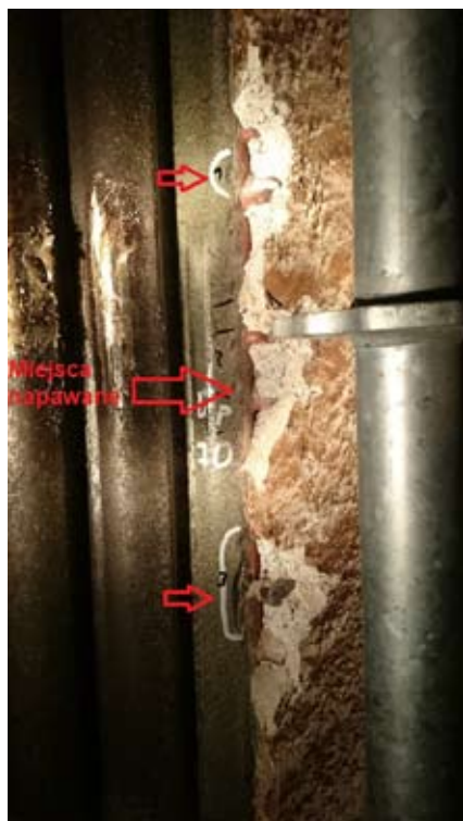
Rys. 11. Naprawa rur ekranowych kotła fluidalnego
