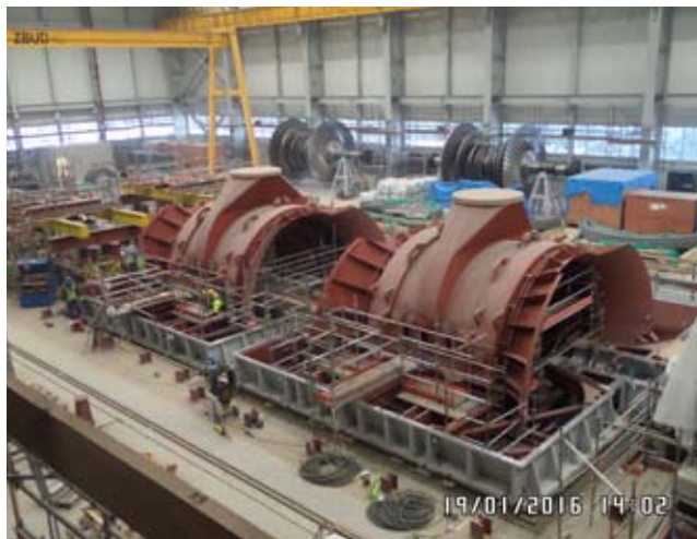
Rys. 17. Część niskoprężna turbiny przed montażem korpusów zewnętrznych
