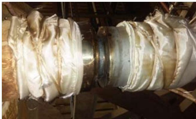
Rys. 16. Gotowy przetop do badania RT
