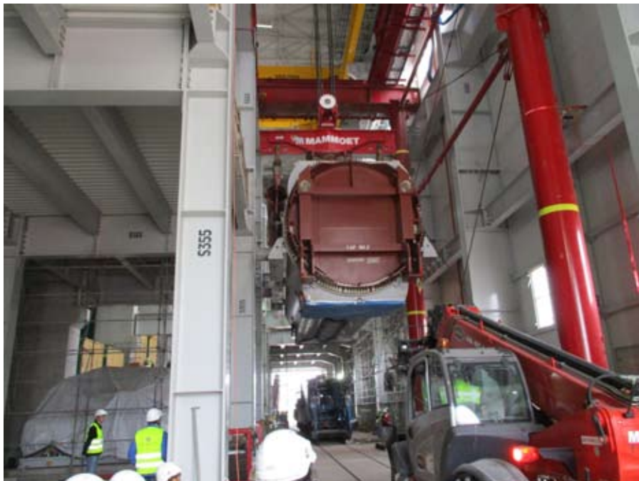
Rys. 14. Montaż stojana generatora na fundamencie przy użyciu specjalistycznego sprzętu
