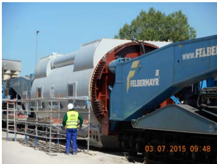
Rys. 13. Stojan na budowie w Kozienicach
