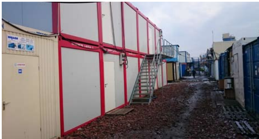
Rys. 7. Kontenery sanitarne i biurowe
