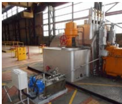
Rys. 17. Turbina Siemens 55 MW po modernizacji- Zasilanie przetworników TM-25 LP
