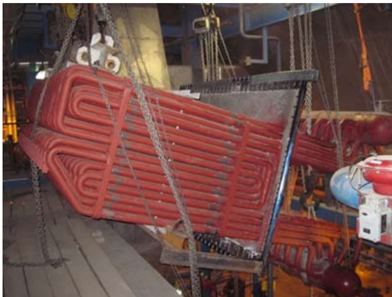
Rys. 10. Transport przegrzewacza INTREX na miejsce docelowe El. Jaworzno II
