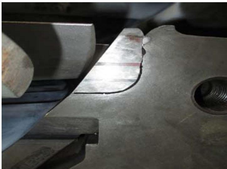
Rys. 9. Modernizacja uszczelnienia nadbandażowego stopnia 3
