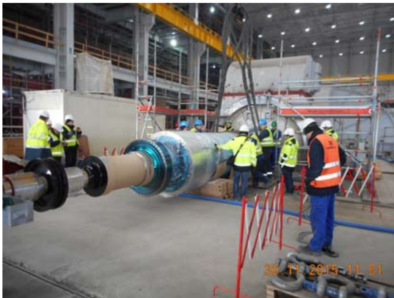
Rys. 15. Montaż wirnika generatora
