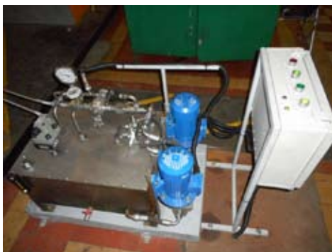
Rys. 18. Turbina Siemens 55 MW po modernizacji- Stacja hydrauliczna
