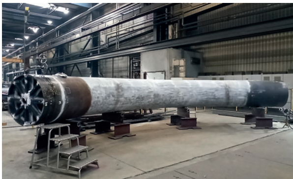
Rys. 6. Rurociąg DN1000 z przyspawanymi dnami płaskimi przygotowany do próby ciśnieniowej
